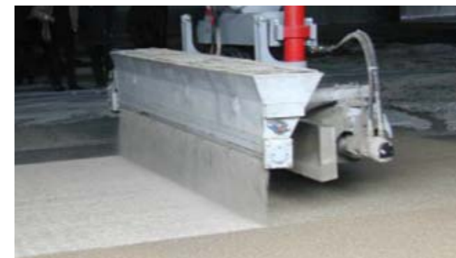
Механизированное нанесение Mapetop N AR6
