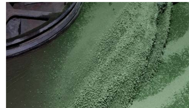
Нанесение Mapetop N AR6 вручную
